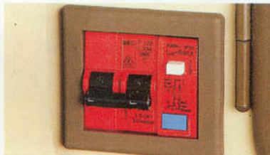
Schutz vor Schaden durch Kurzschlüsse: der Personenschutzautomat.
